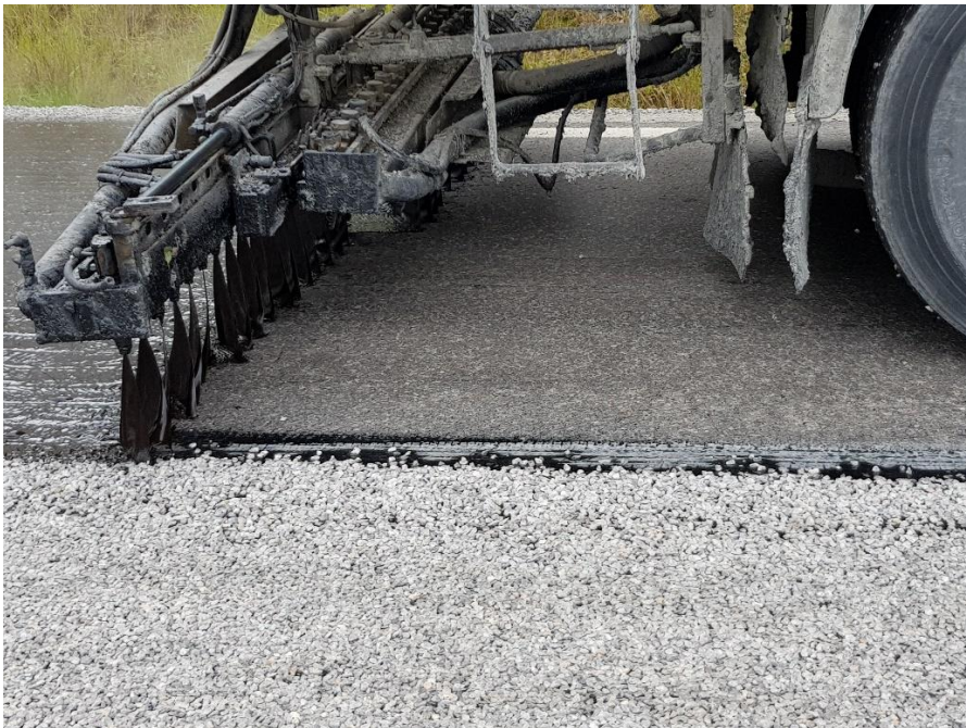
Bild 1. Fel inställning av munstycken
