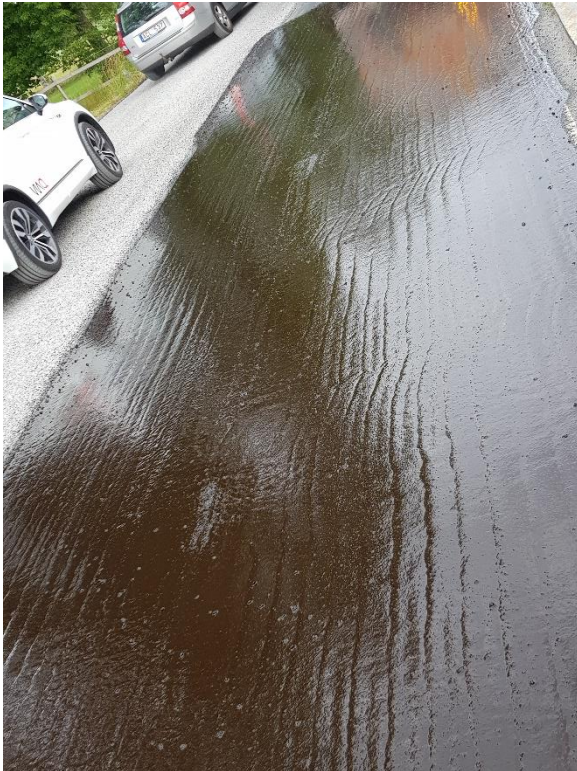
Bild 2. Munstycken öppnar inte som förväntat med ojämn spridning, randning som följd
