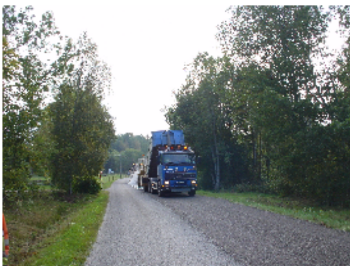
Bild 7 Spridning av andra bindemedelsgivan och tätningmaterial.
