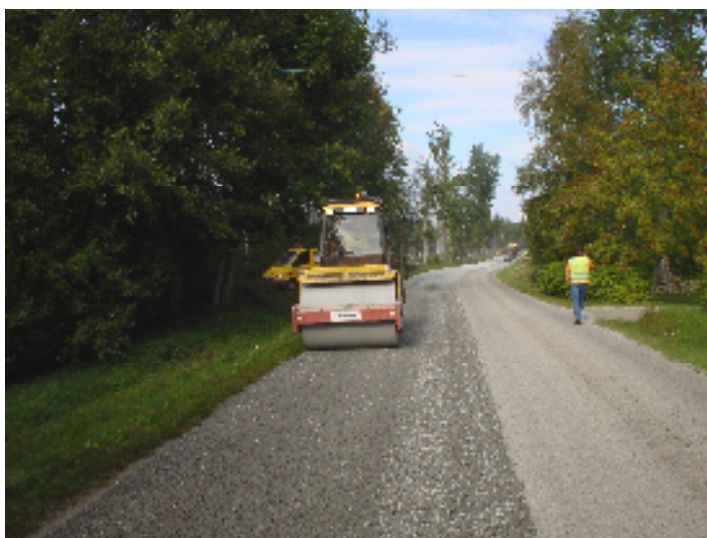
Bild 6 Packning av IM och kilsten.
