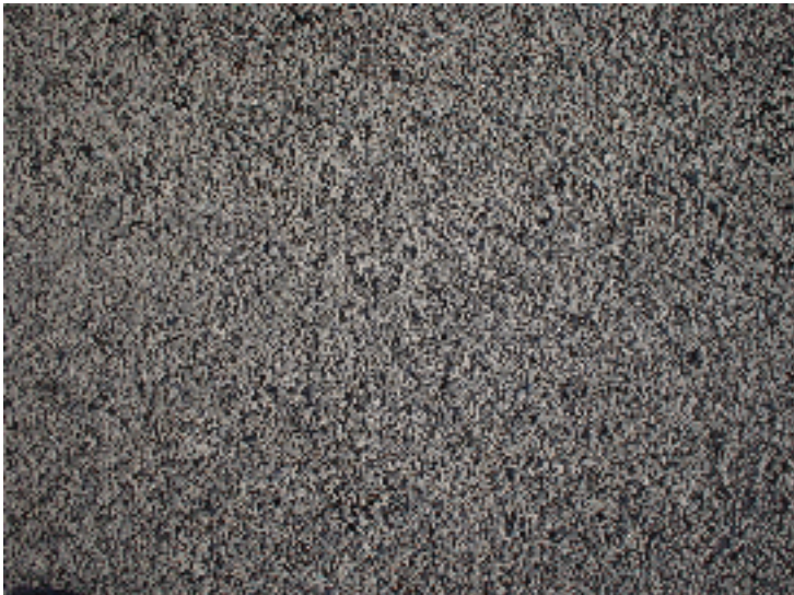
Bild 3 Nypackad yta innan indränkning med bitumenemulsion.
