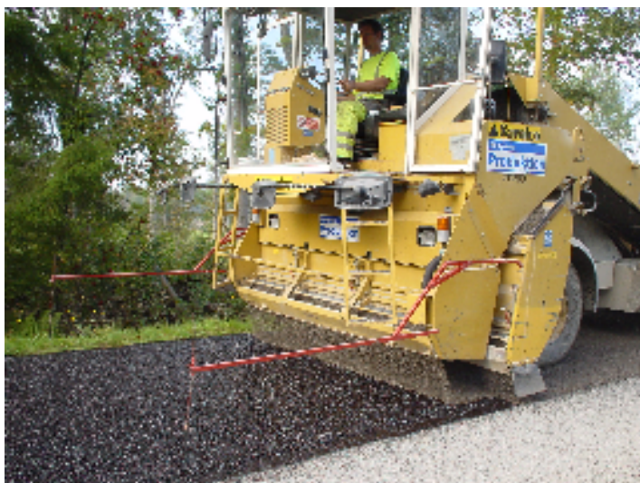
Bild 8 Spridning av 0-8 mm för tätning av ytan.
