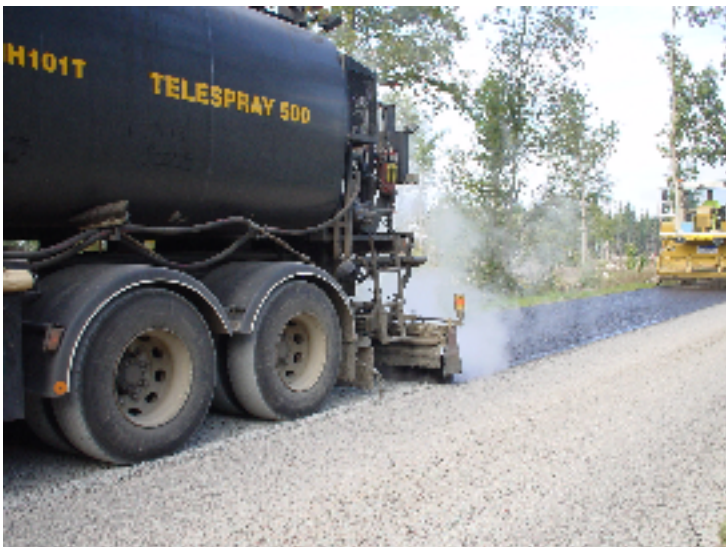
Bild 4 Spridning av första bindemedelsgivan.
