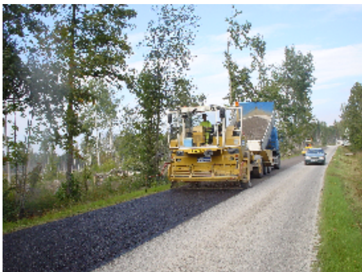
Bild 5 Spridning av kilsten, 8-11 mm.
