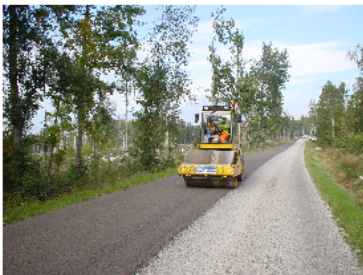
Bild 9 Vältning efter spridning av tätningsmaterialet.
