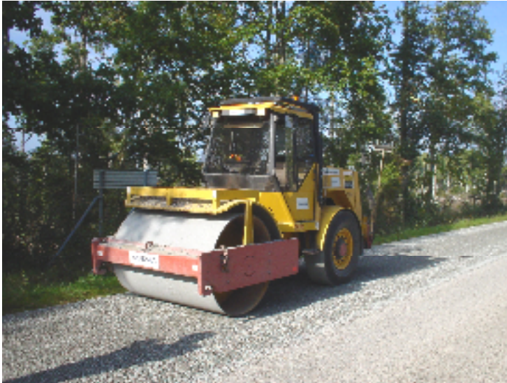
Bild 2 Vältning av IM-lagret.
